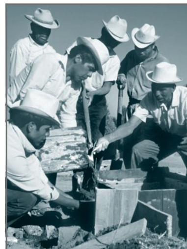
Arriba: Voluntarios trabajando en un canal de irrigación (México)
